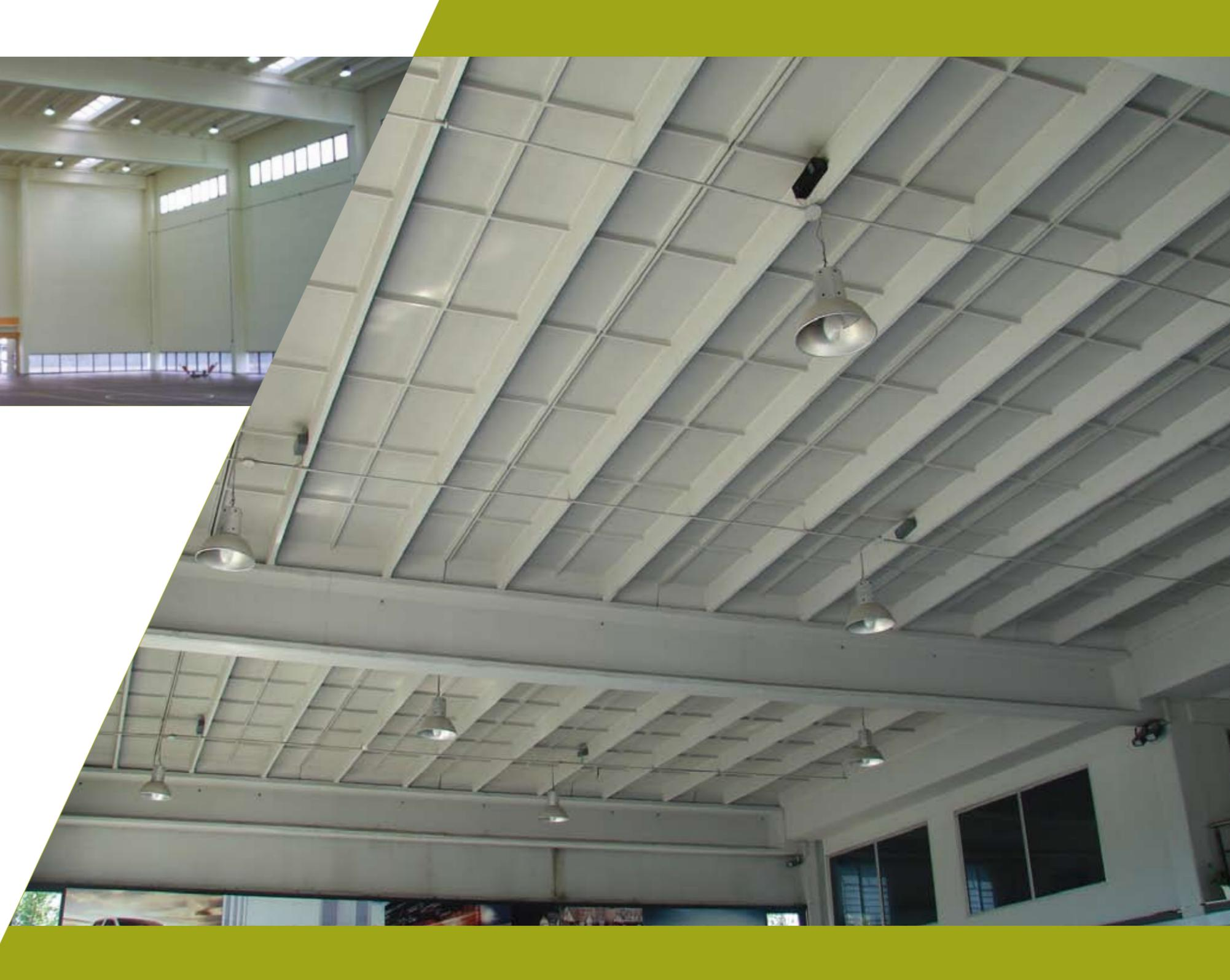
DETALLE VIGA PRETENSADA PARA TECHO Y PARA PUENTE GRÚA
