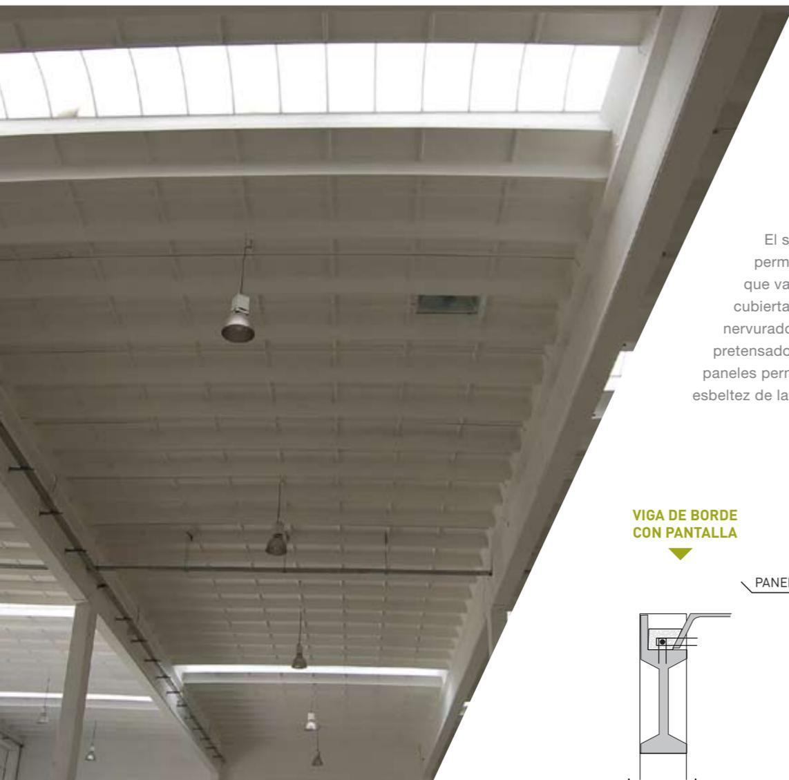
El sistema Pi es un tipo de cubierta plana que permite cubrir grandes superficies con módulos que van desde los 10x10m a 10x30m. Como cubierta propiamente dicha se emplean paneles nervurados de hormigón prefabricados. El pretensado de los nervios longitudinales de los paneles permite optimizar el diseño y aumentar la esbeltez de la pieza reduciendo su peso.
